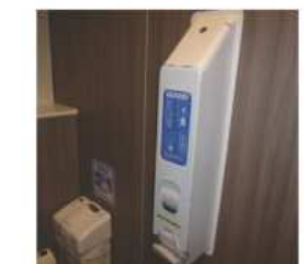
丸の内線東京駅
