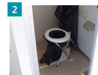
2 和式トイレを緊急的に簡易トイレへ
